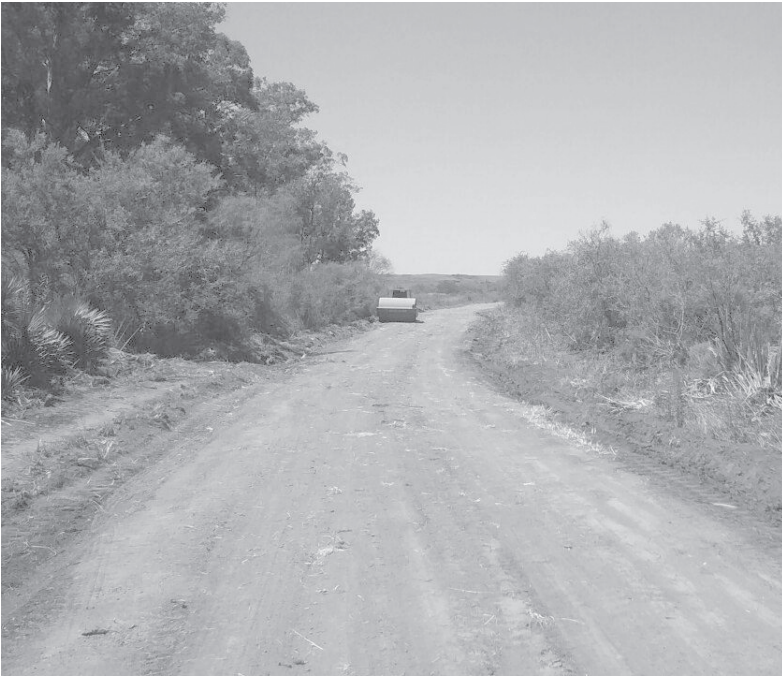
Trecho recuperado na região do Sarandi, compactado (Foto: Divulgação/Ascom)
