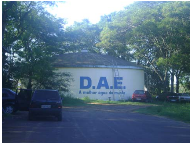
4 – Reservatório Apoiado RAP-HI-01
