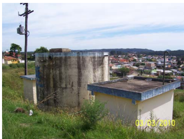
27 – Reservatório Apoiado RAP-JV-01
