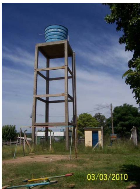
54 – Reservatório Elevado REL-RO-01
