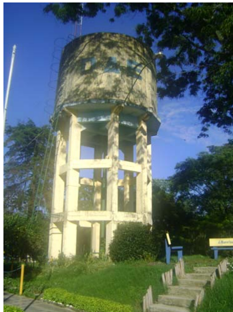
5 – Reservatório Elevado REL-HI-01
