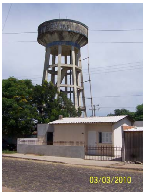
40 – Reservatório Elevado REL-KE-01
